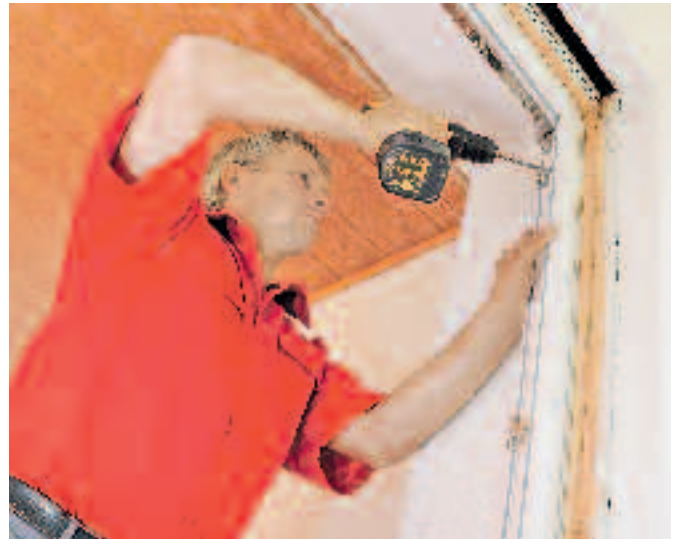
Schritt 4: Für einen sicheren Halt im Mauerwerk verschrauben Sie die Einschubprofile auf dem gestutzten Rahmen an mehreren Stellen.
