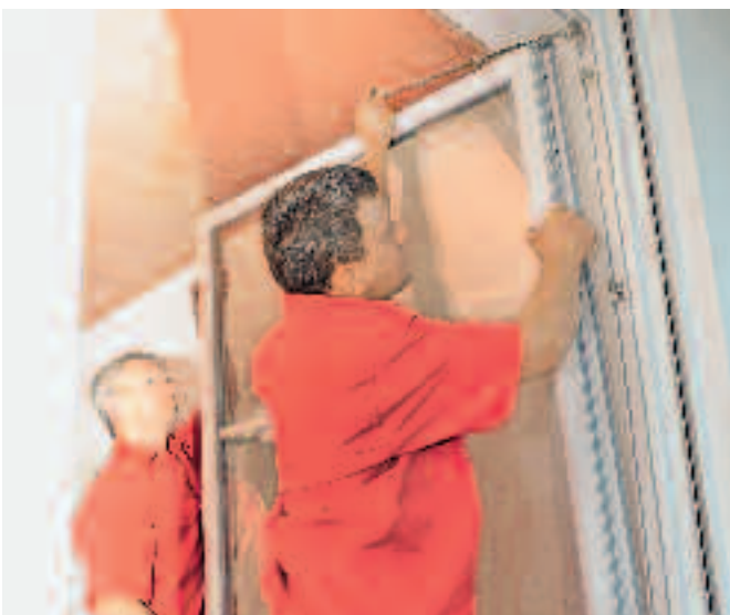
Schritt 7: Hängen Sie die neuen Fensterfügel ein und justieren Sie die Beschläge für leichtgängige Bedienung. Dabei helfen ein paar Spritzer Spezial-Öl auf die beweglichen Beschlagteile.
