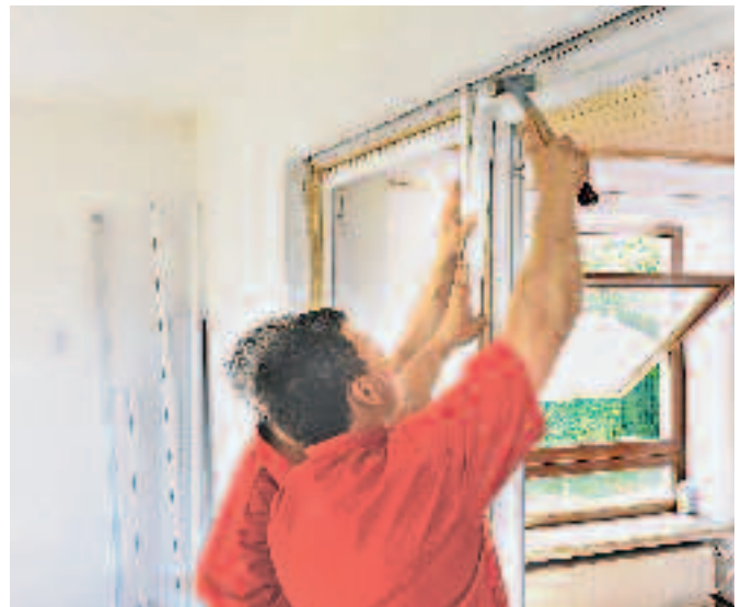
Schritt 6: Danach setzen Sie den äußeren Fensterrahmen auf und verbinden ihn mithilfe des speziellen Aufnahmeprofils fest mit dem inneren Rahmen. So sanieren Sie auch große Elemente.
