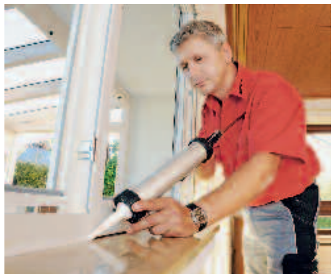
Schritt 8: Zum Schluss fugen Sie den Anschlussbereich des neuen Fensters ringsum aus. Tapete, Putz und Fliesen bleiben dabei unbeschädigt. Nacharbeiten am Mauerwerk sind nicht nötig.
